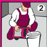
2. Для подготовки раствора залейте водопроводную воду комнатной температуры в чистую ёмкость из расчёта 8,8-9,6 л воды на 1 мешок (25 кг).
