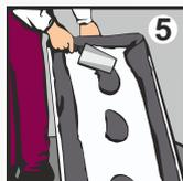
5. Для оснований, с неровностями не более 3 мм на 2 м по длине стены: нанесите раствор с помощью зубчатого шпателя (с размером зуба 8x8мм) полосами по периметру листа, с отступом 3-4см от края, и дополнительно 1-2 полосы посередине по длине листа. Для оснований с неровностями 3-20мм: нанесите клей «лепешками» диаметром 10-12см с небольшими интервалами по периметру листа и дополнительно, по всей площади листа с интервалом 30-40 см.
